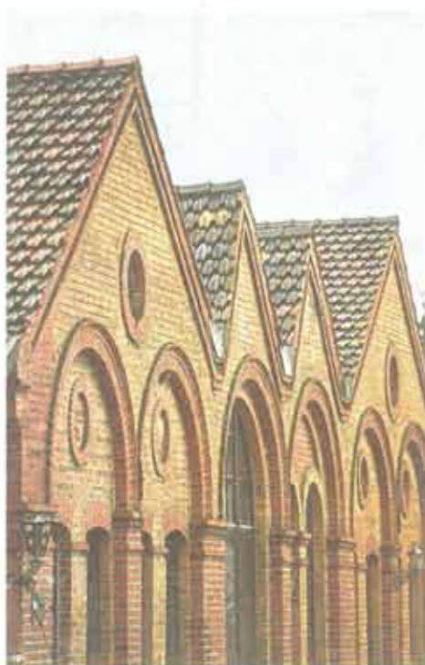
Möglichst viele der alten Bauten der Ziegelei sollen saniert werden. Foto: Gottfried Stoppel
